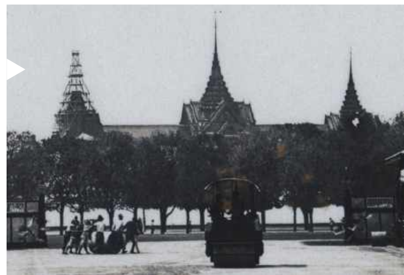
Fig 4. การตั้งนั่งร้านเพื่อซ่อมแซมพระที่นั่งจักรีมหาปราสาท องค์ตะวันออก ถ่ายเมื่อวันที่ 16 ธันวาคม 2472
